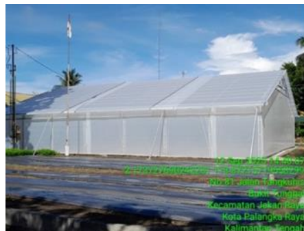
Gambar 82. Pemasangan atap UV Drayer Lantai Jemur UPBS BRMP Kalimantan Tengah
