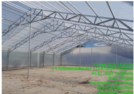
Gambar 51. Pemasangan atap UV Dryer Lantai Jemur UPBS BRMP Kalimantan Tengah
